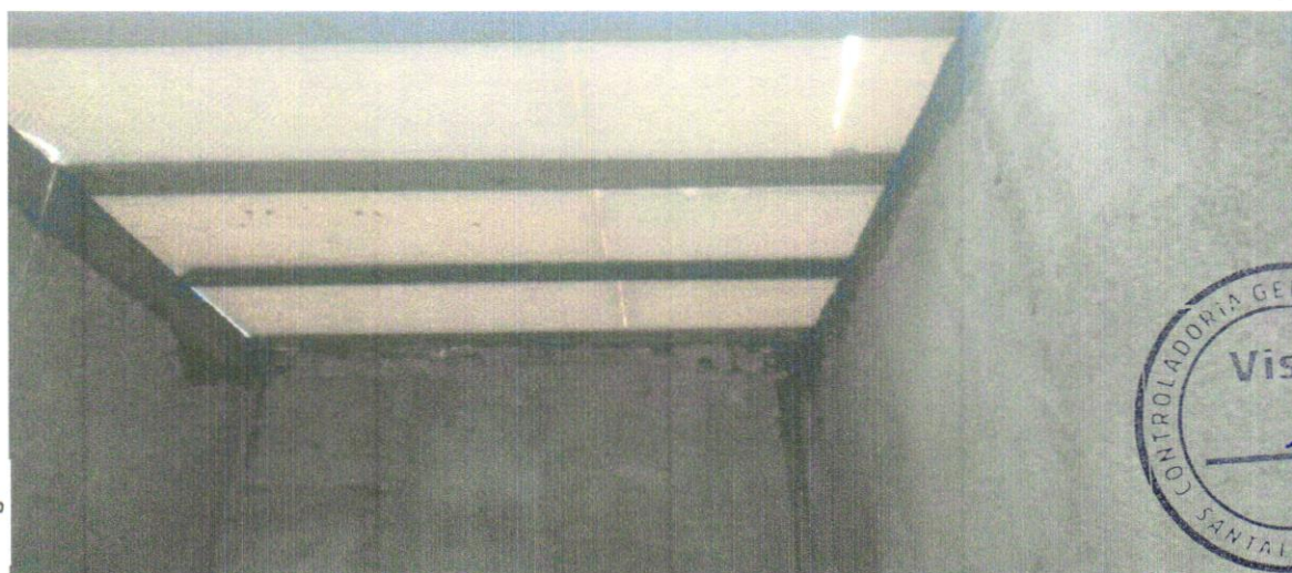
FOTO 02 – - Laje pré-fabricada treliçada para piso ou cobertura, intereixo 38cm, h=12cm, el. enchimento em EPS h=8cm, inclusive escoramento em madeira e capeamento 4cm.
