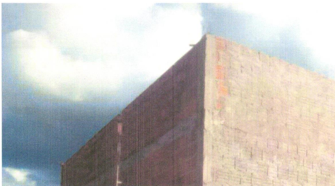
FOTO 01 – (COMPOSIÇÃO REPRESENTATIVA) EXECUÇÃO DE ESTRUTURAS DE CONCRETO ARMADO, PARA EDIFICAÇÃO HABITACIONAL UNIFAMILIAR TÉRREA (CASA EM EMPREENDIMENTOS), FCK = 25 MPA. AF_01/2017
