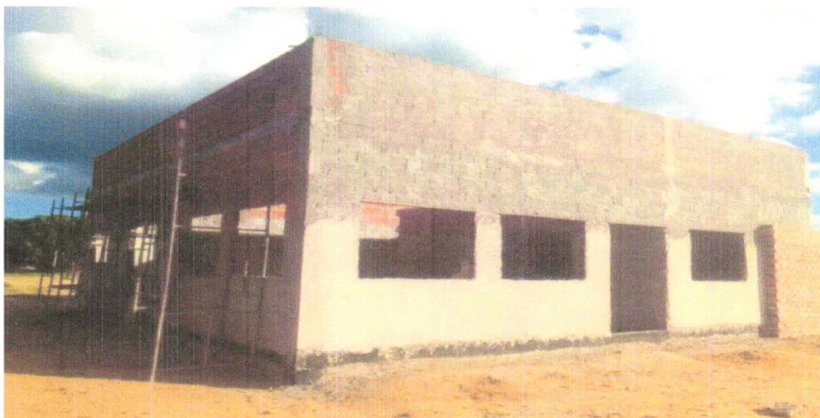
FOTO 05 – CHAPISCO APLICADO EM ALVENARIAS E ESTRUTURAS DE CONCRETO INTERNAS, COM COLHER DE PEDREIRO. ARGAMASSA TRAÇO 1:3 COM PREPARO EM BETONEIRA 400L. AF_06/2014
