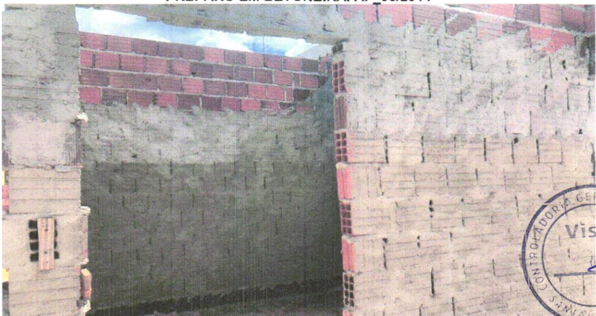
FOTO 04 - CHAPISCO APLICADO EM ALVENARIAS E ESTRUTURAS DE CONCRETO INTERNAS, COM COLHER DE PEDREIRO. ARGAMASSA TRAÇO 1:3 COM PREPARO EM BETONEIRA 400L. AF_06/2014
